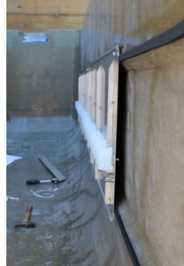
Abb. 3 – Modell einer Parallelströmplatte (PFP, links) und Ansicht während des Einbaus bei den Montanwerken Brixlegg AG
